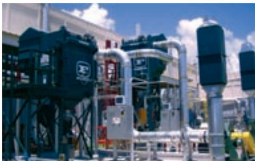
Mehrfach GS Staubabscheider bei Tablettenbeschichtung
