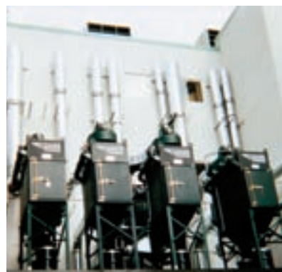
Gold Series® installation på svetsrök
