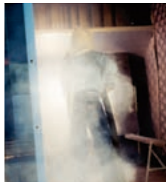
Termisk sprutbås innan Gold Series® filtersystem är installerat
