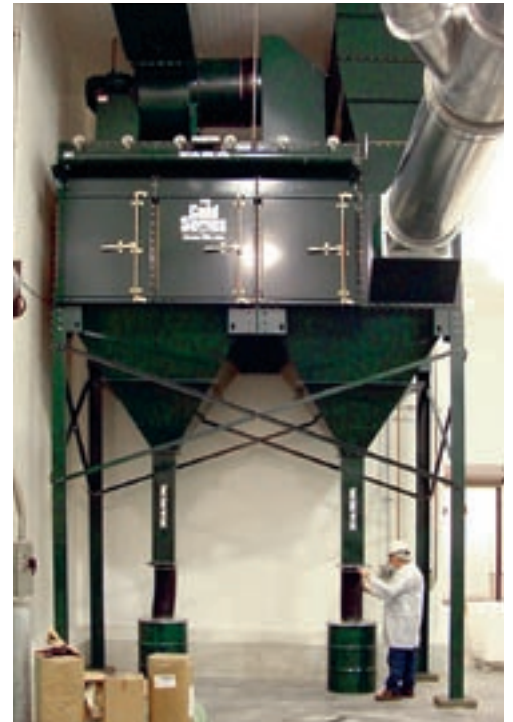
GS24 ansluten till sughuvar vid vägstationer för kryddor
