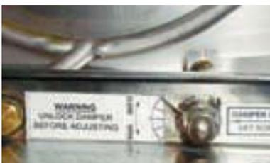
Indicateur de position et vis de réglage du registre guillotine ou BT.
