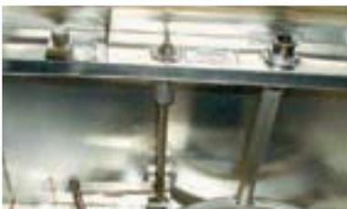
Système de dispersion d'aérosol avec prises à débranchement rapide et mécanisme de contrôle du registre.
